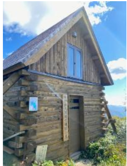
三角屋根の避難小屋
