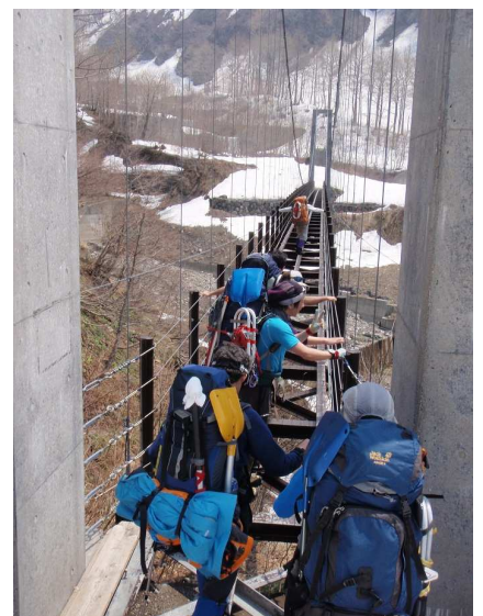
別当出合の吊り橋
